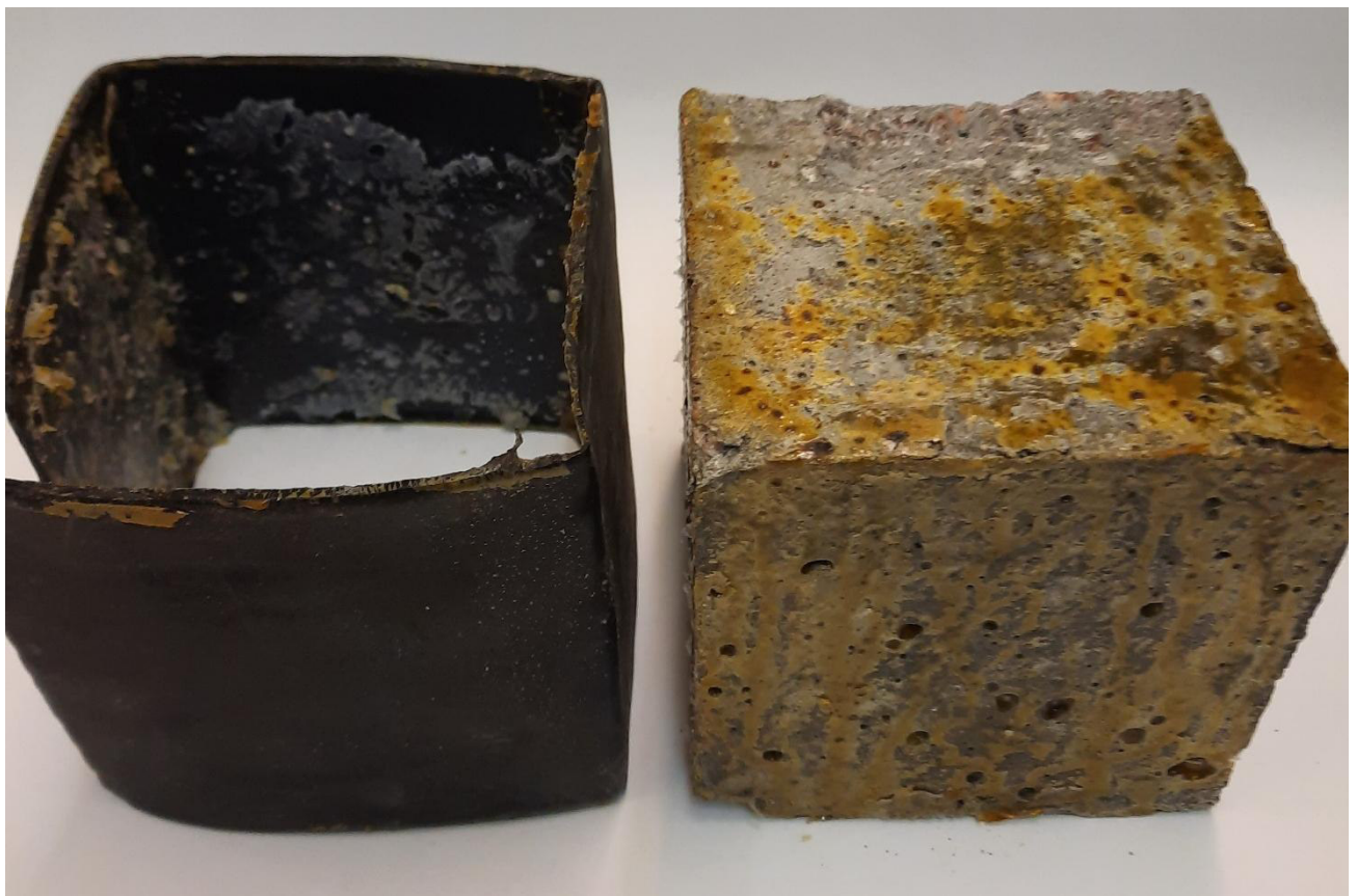
Рисунок 12 – Внешний вид бетонных образцов с системой покрытия ОСПТ«Reline» после 20 циклов замораживания-оттаивания
